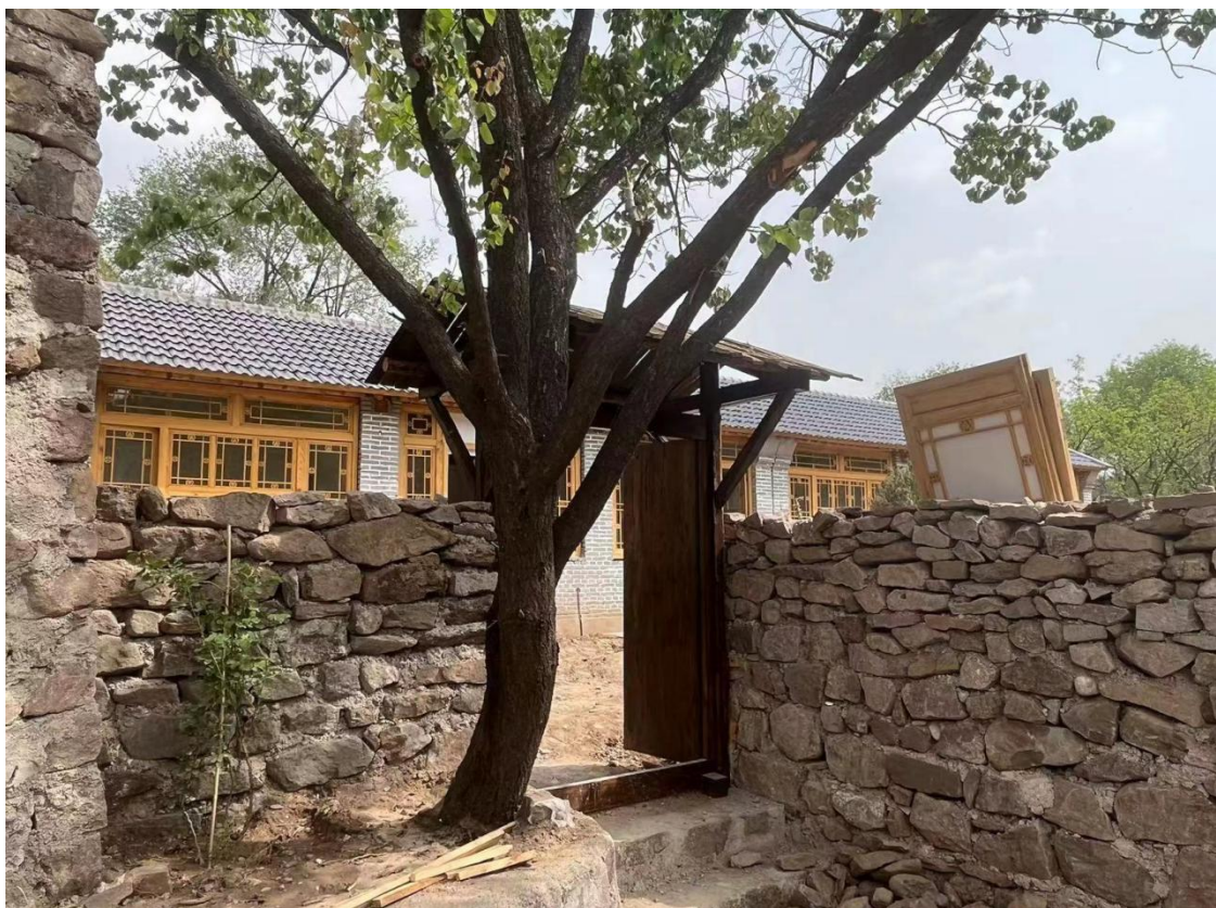
图 3 改造完成的农宅
